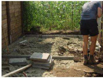
Und in dem Kennel für die Terrier sind auch schon einige Pfostenschuhe einbetoniert. Der Kies wurde dort noch nicht verteilt.
